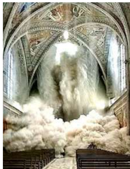
il crollo della volta della basilica di San Francesco in Assisi nel 1997
