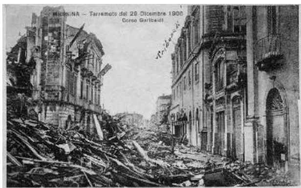
Terremoto di Messina del 1908
