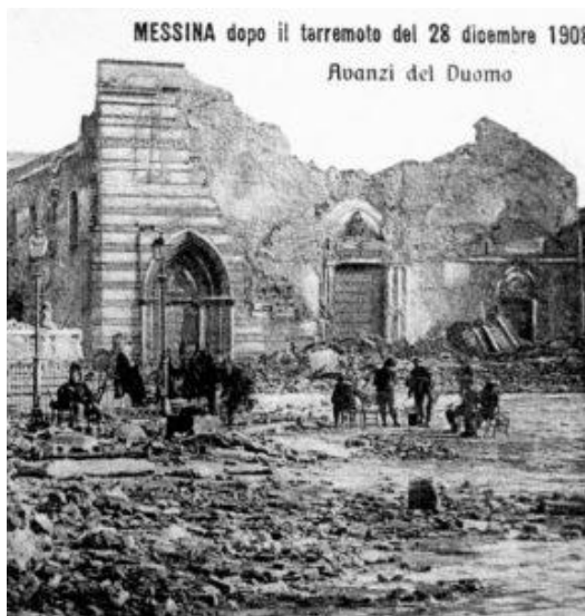
I resti della cattedrale metropolitana di Messina dopo il terremoto del 1908
